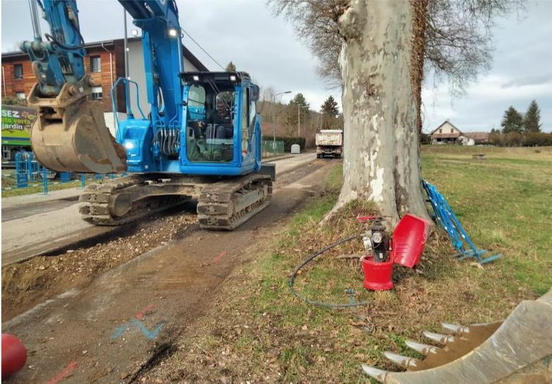
MISE EN CONFORMITE DU RESEAU D'ASSAINISSEMENT DE ST ALBIN DE VAULSERRE : Ces travaux ont démarrés en juillet 2024 et sont terminés (855 ml de canalisations gravitaires FD200 et de 100 ml de canalisations pression FD80). Le lot génie civil (PERROUSE CONSTRUCTIONS) : la réalisation de l'ouvrage en béton est en cours. Les travaux du lot équipements électromécaniques (SADE) sont en cours pour le raccordement de l'ouvrage et la mise en place des équipements électriques.
