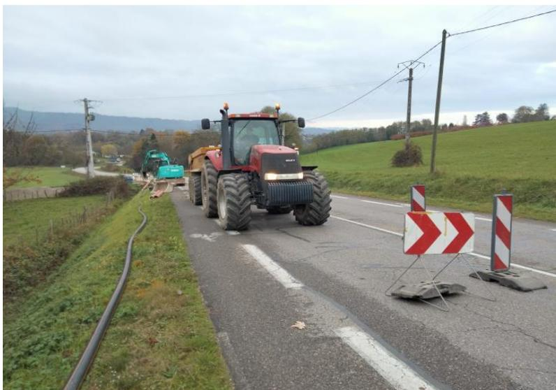
**MISE EN CONFORMITE DU RESEAU D'ASSAINISSEMENT DE ST ALBIN DE VAULSERRE** : Ces travaux ont démarrés en juillet 2024 et sont terminés (855 ml de canalisations gravitaires FD200 et de 100 ml de canalisations
